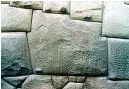
Construcción de un muro en el Cusco, con tallados angulares. Las piedras están unidas sin argamasa
