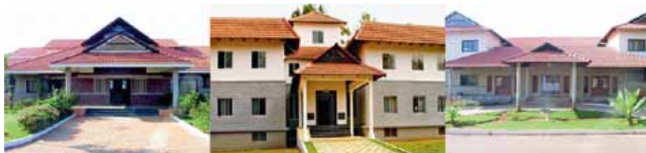
Oficinas, aulas y laboratorios del Instituto de Ayurveda y Medicina Integrativa (I-AIM) en Bangalore.
