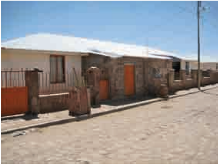
Imagen 28: las casas al estilo de campamentos se ensanchan con materiales tradicionales
