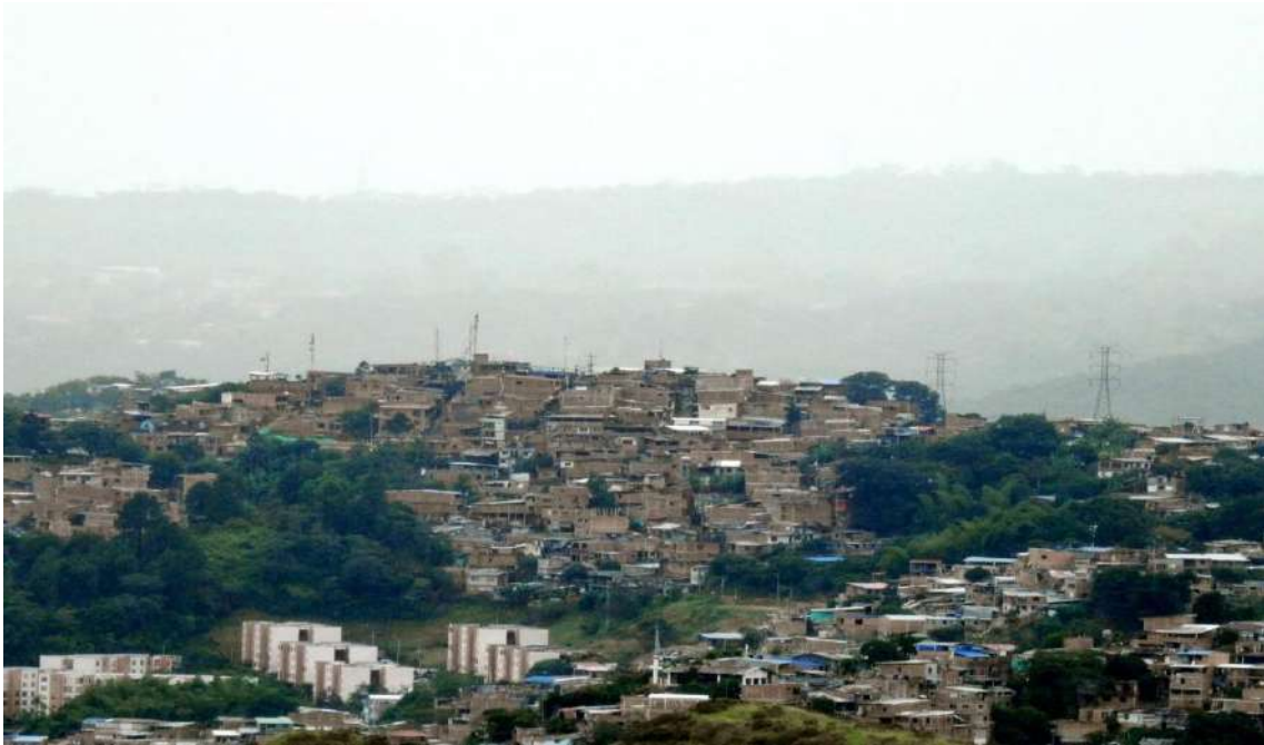
Figura 3. Asentamientos en laderas
