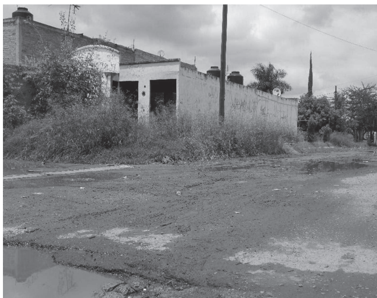
Figura 2. Calle Álamos, fraccionamiento La Azucena, deterioro evidente de calles, abandono de casas y aguas contaminadas mezcladas con aguas negras
