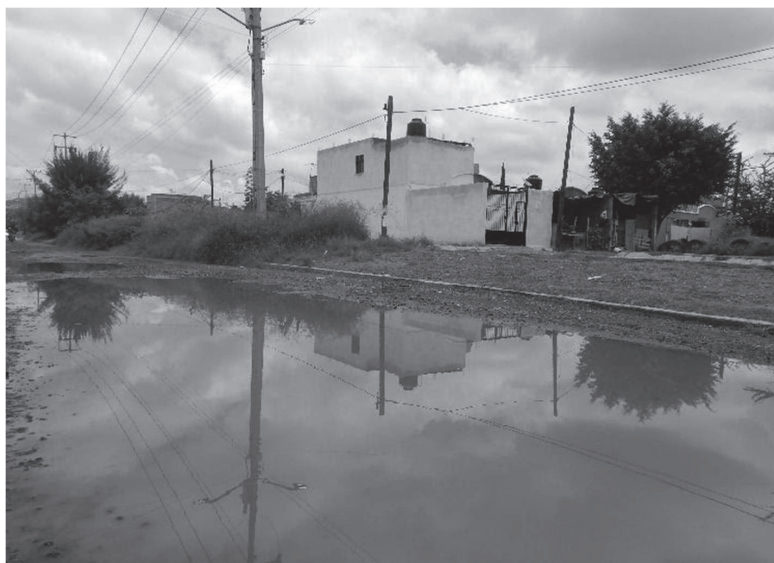
Figura 1. Calle Azucenas, fraccionamiento La Azucena, calles anegadas de aguas del río Santiago mezcladas con aguas negras de tuberías desbordadas
