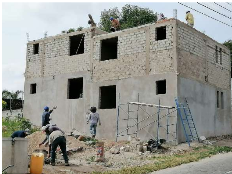
Imagen 42. Construcción de Las Casitas
