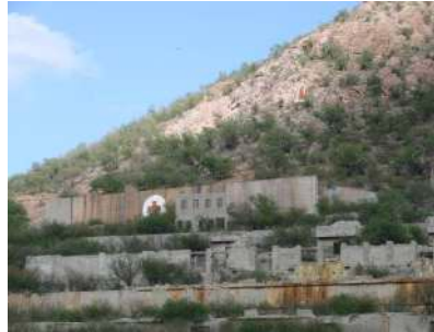
Imagen 61. Más arriba de los cimientos, está la pintura.
