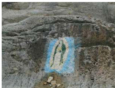
Imagen 69. Se aprecia ya muy deteriorada la pintura.
