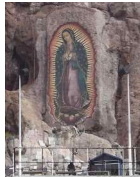
Imagen 88. Se ve el concreto donde fue pintada.
