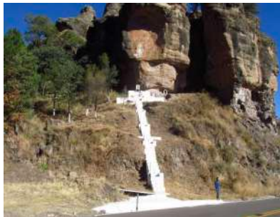
Imagen 37. Vista general del paraje de Los Pilares.
