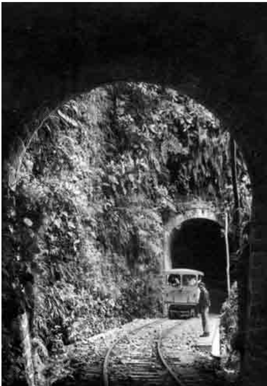
Vistas de túneles del ferrocarril (AHMCE), 85.F0127.079
