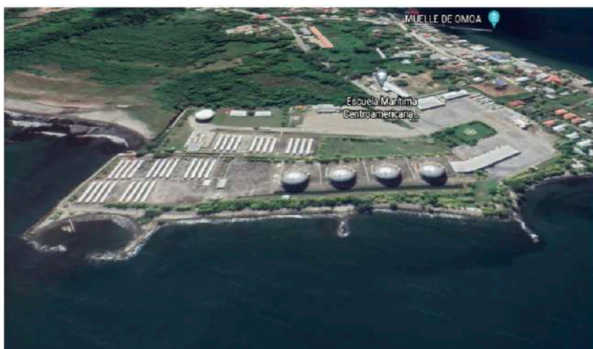
Instalaciones de la Empresa Gas del Caribe del grupo TOMZA de capital mexicano en la Bahía de Omoa, Honduras. Fuente: Earth Google. 6 de mayo 2021.
