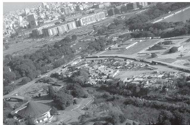
IMAGEN 2. Vista aérea de la ex ciudad deportiva de Boca Juniors abajo a la izquierda; la Villa Rodrigo Bueno al centro; la Reserva Ecológica arriba a la derecha; y Puerto Madero arriba a la izquierda (Bruno Goroni, 2005).
