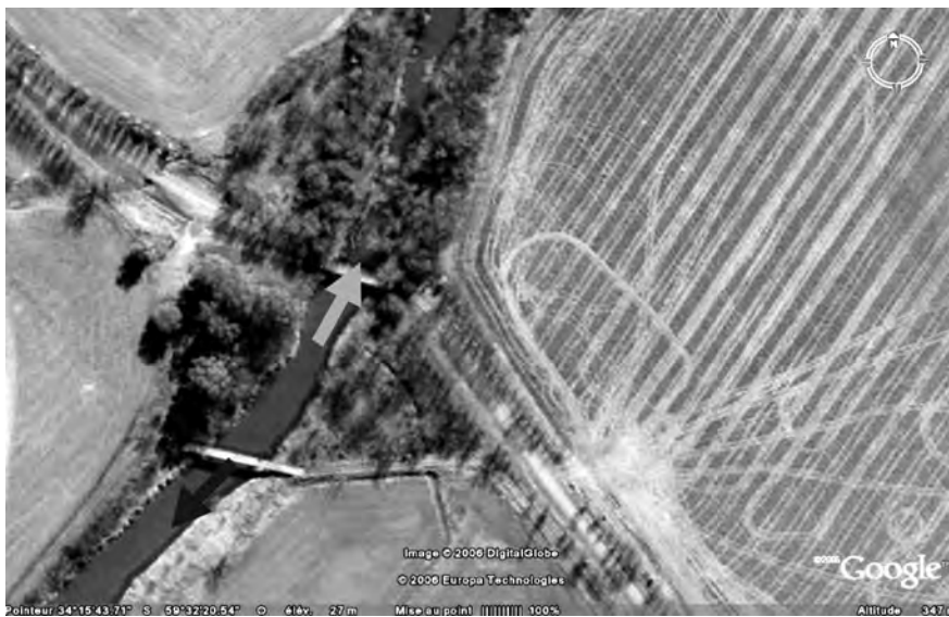
Foto 6. Puente sobre el Río Areco Arriba.
