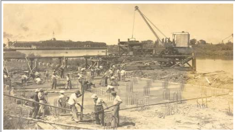
Foto 1.1 Obreros realizando el hormigonado
