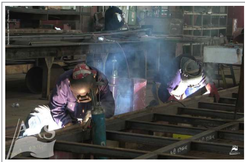
Foto 9 Taller de estructuras: proceso de soldadura
