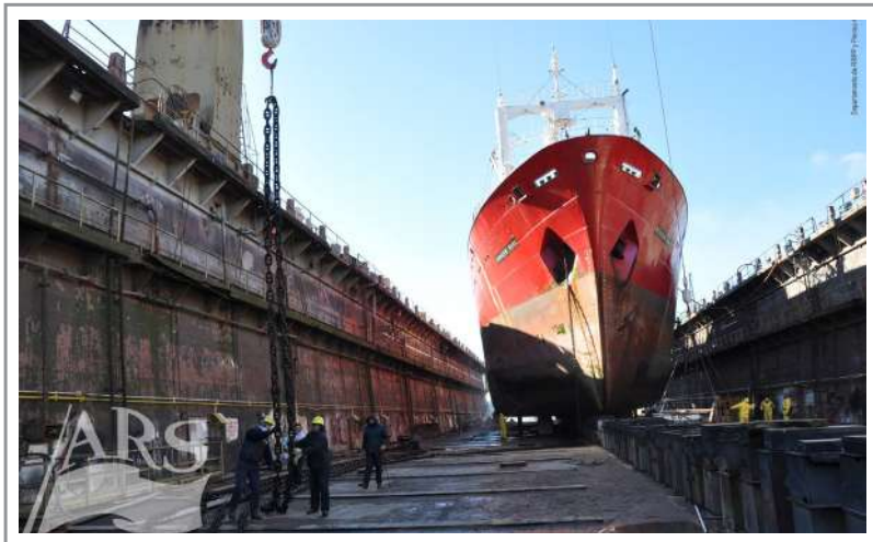
Foto 3 Dique flotante: reparación de buque
