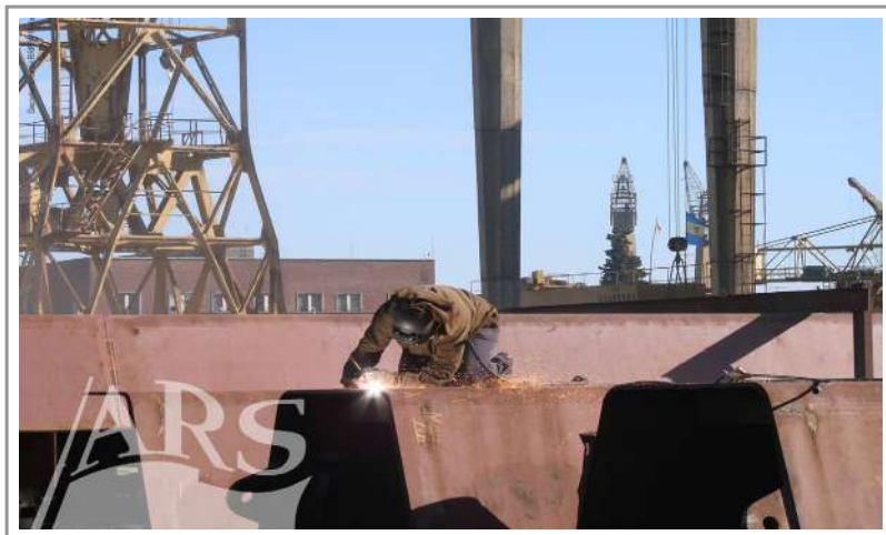
Foto 10 Soldadura en prefabricado
