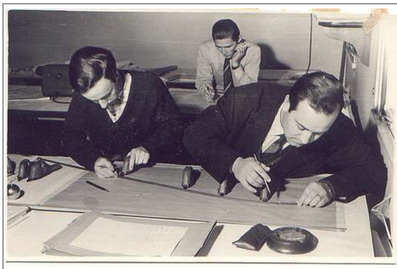
Foto 2.1 Trabajos de diseño y cálculos en la Oficina Técnica
