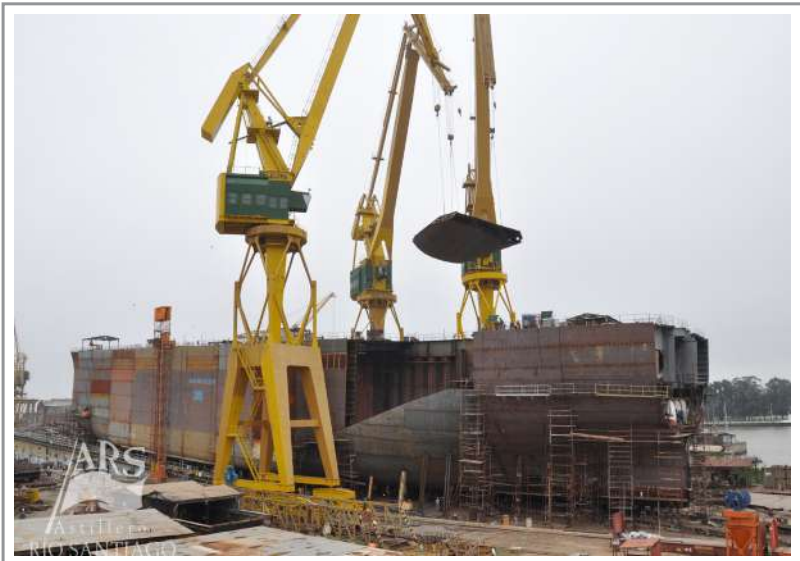
Foto 12 Sector de gradas: montaje de bloque lateral
