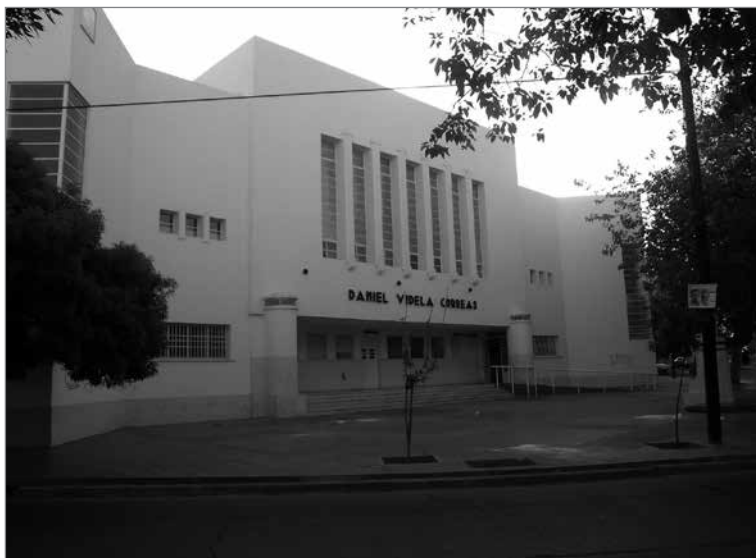
Imagen 4. Escuela Videla Correás, fachada. Foto: Daniela Cattaneo.
