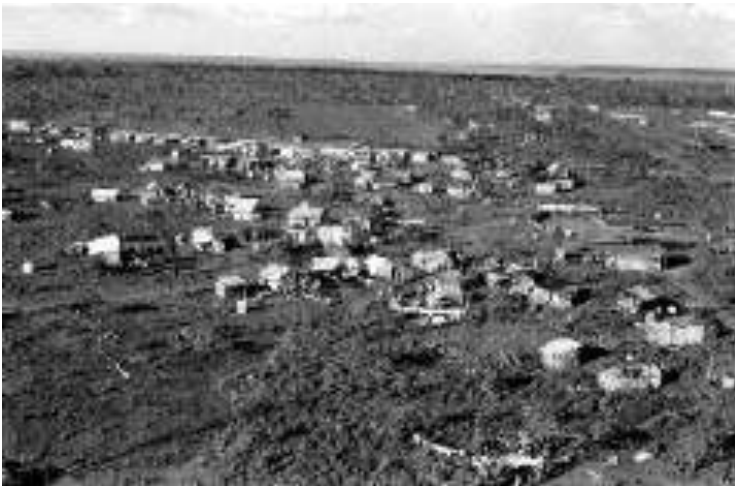
Habitaciones de trabajadores próximas a la construcción de la Supercuadra Sur 108, septiembre de 1958. Foto de Mário Fontenelle.
