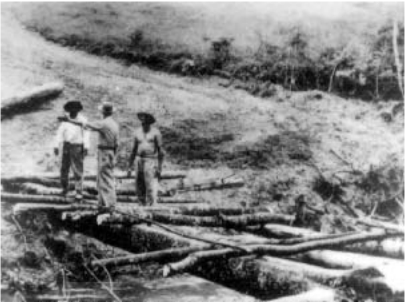
Construcción de un puente para llegar a Brasilia, 1956
