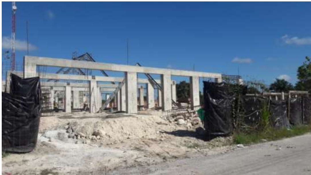
Construcción de las nuevas instalaciones municipales de Xpujil, Campeche.
