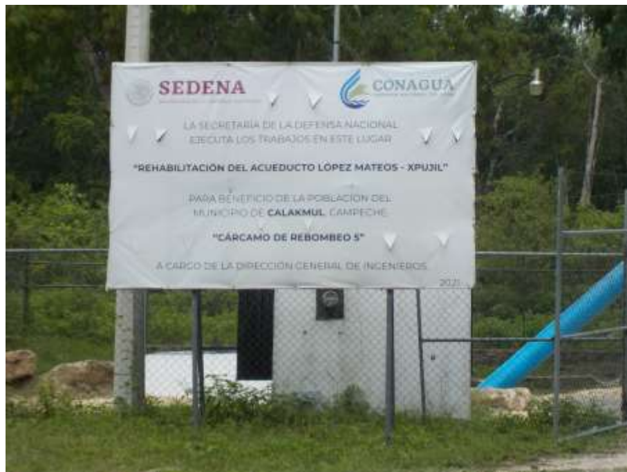
Cárcamo de Rebombeco 5 del Acueducto López Mateos-Xpuhil. Rehabilitación a cargo de la Dirección General de Ingenieros de la SEDENA. Foto: Marcela de Lourdes Orozco Contreras, agosto de 2021.
