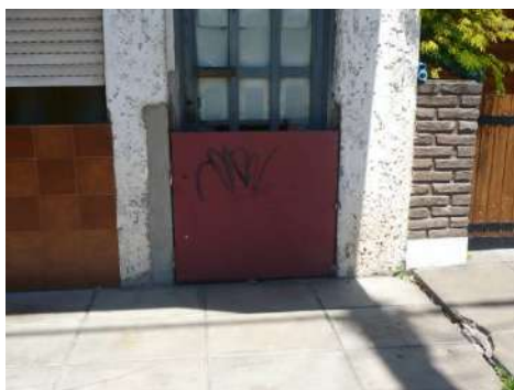
Foto 18. Vivienda con compuerta
