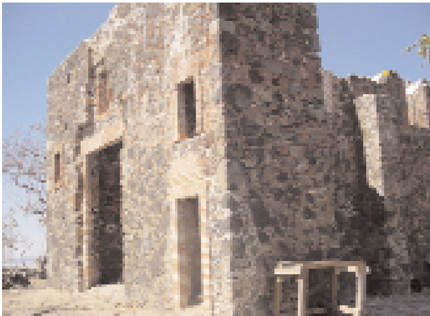
Figura IV. Restos de una de las antiguas capillas en la Isla de Mezcala.
