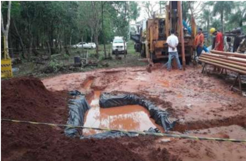
Imagen 7. Inicios de la perforación del pozo artesiano
