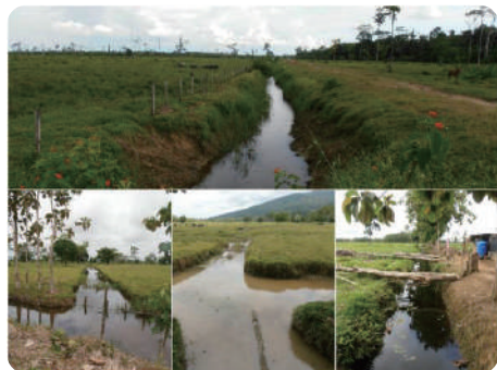
Figura 3. Canalizaciones realizadas por fincas ganaderas
