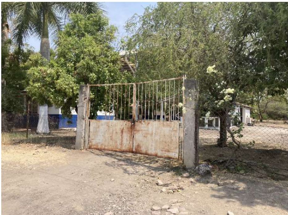
La escuela telesecundaria de La Esperanza. Fotografía propia (2021).
